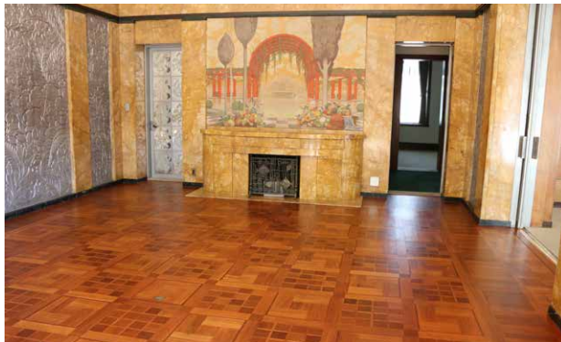
大食堂寄木床糊の除去作業後の写真
