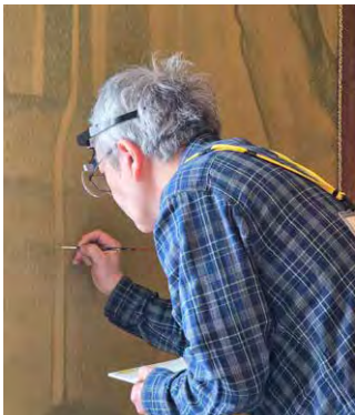
小客室壁画の補修作業の様子
