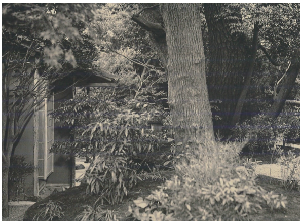
図8 「光華」小間北側古写真(竣工写真アルバム、平田建設蔵) 左手の外壁位置が現在より後退している。
