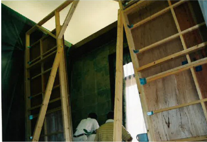
壁面からの剥がし作業
