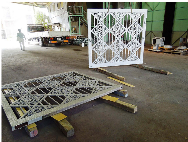
左：塗装完了、右：塗装剥がし後
