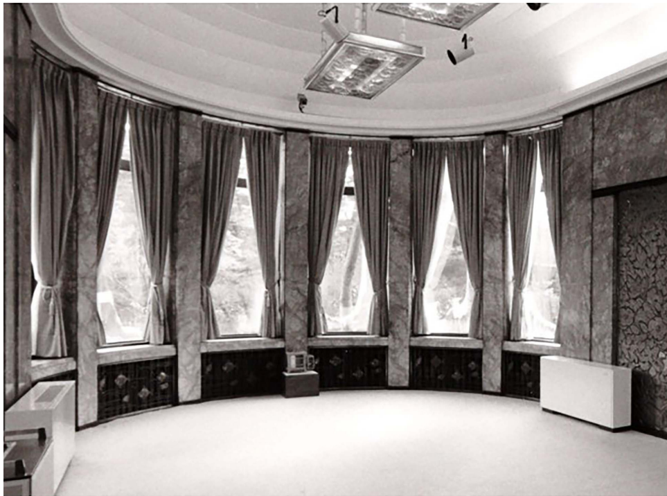
空調機（写真左右下）
