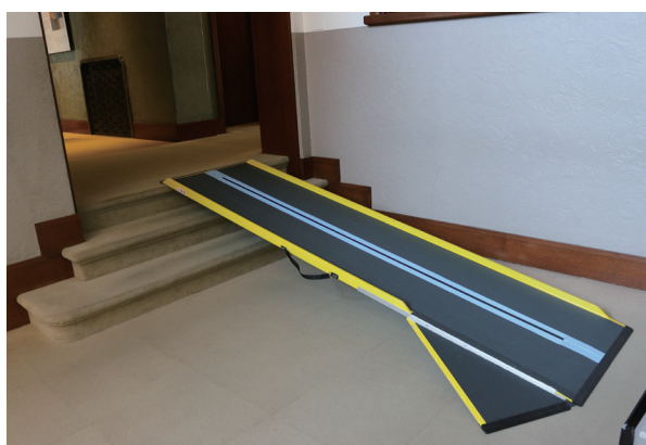
図2 本館2階の仮設スロープ
