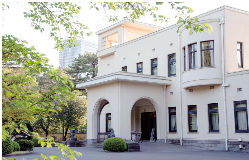
図13-1 (1-2-k) 本館の外壁（リシン掻き落とし）
