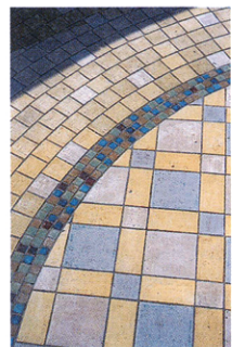
図4. バルコニー・タイル修復後
