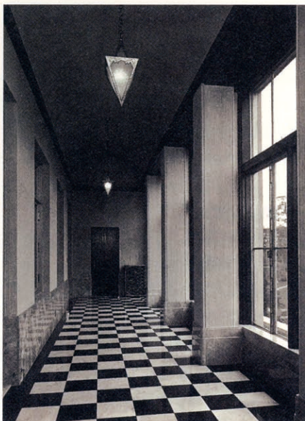
ベランダ(竣工当時)
