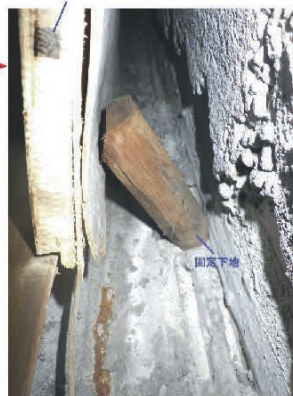
写真24:②側面の固定下地 写真23拡大
