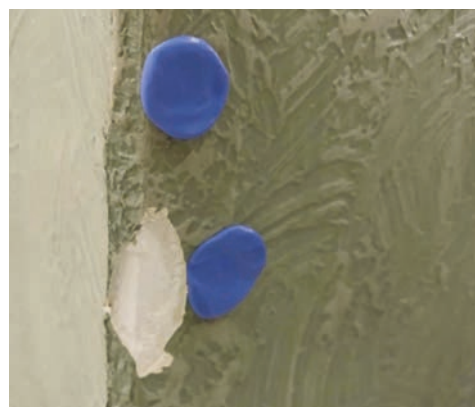
(1-5 写真8) ②下地作成：型取りの様子 ブルーのシリコン系材料で壁から型をとり、ソーダ石灰方形酸ガラスで整形する
