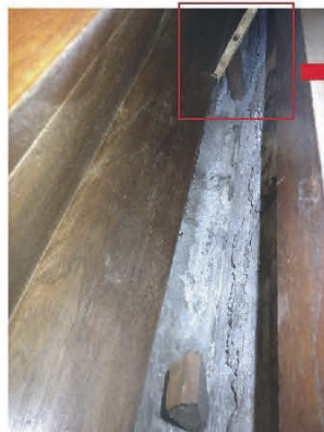
写真23:②側面の固定下地 大広間カーテンボックスNo.1
