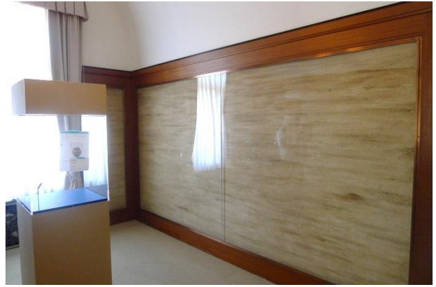
写真 7-6 2階合之間のラフコート塗
