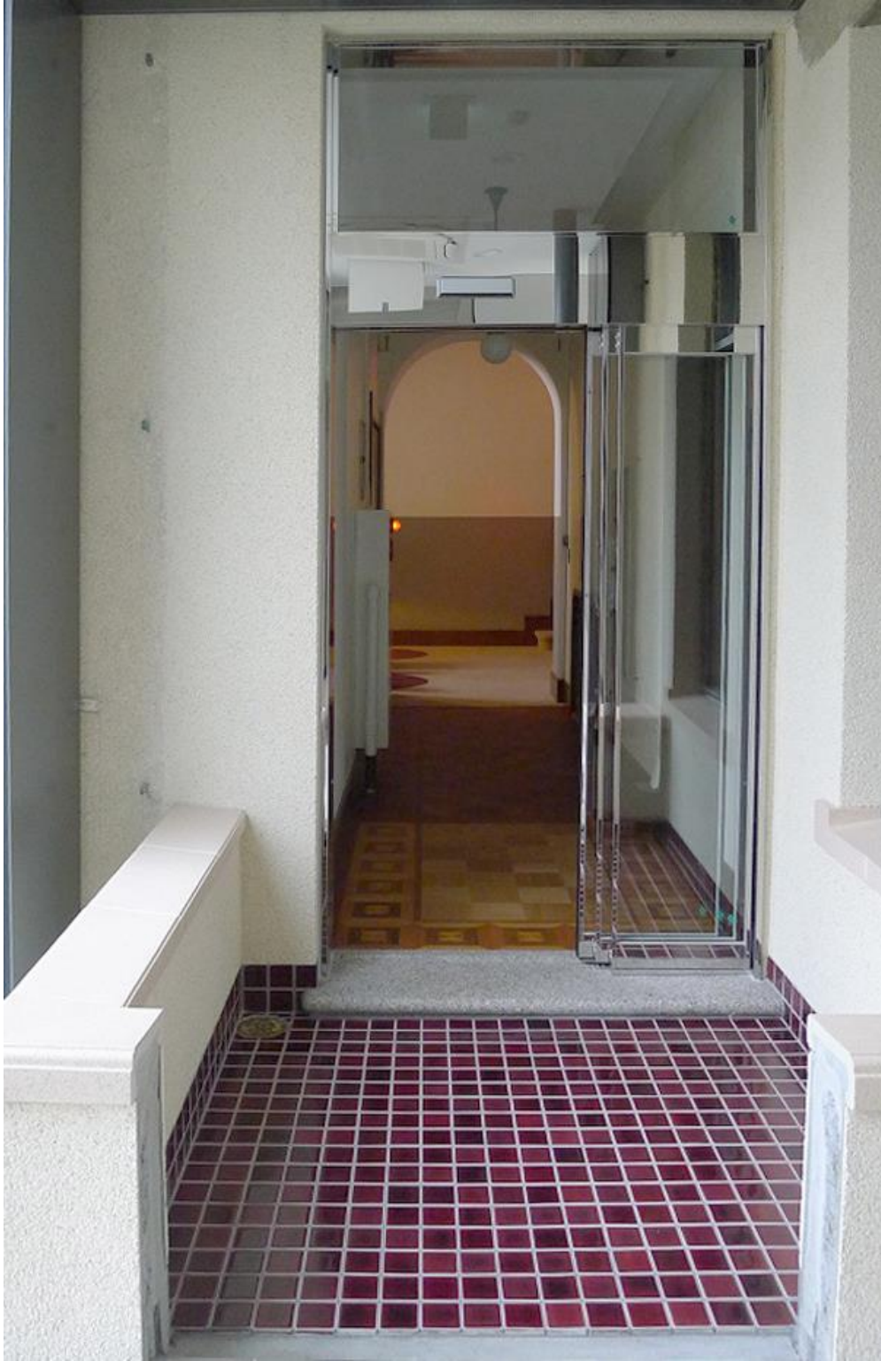
9 本館二階バルコニー（東面・竣工）
