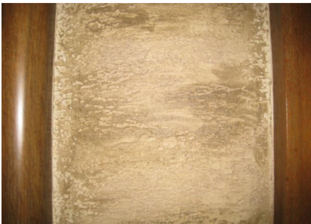
写真 7-5 1階受付外套室のラフコート塗
