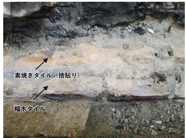
写真 4-3 捨て貼り用素焼きタイル 幅木タイルの後ろに素焼きタイルの捨て貼り
