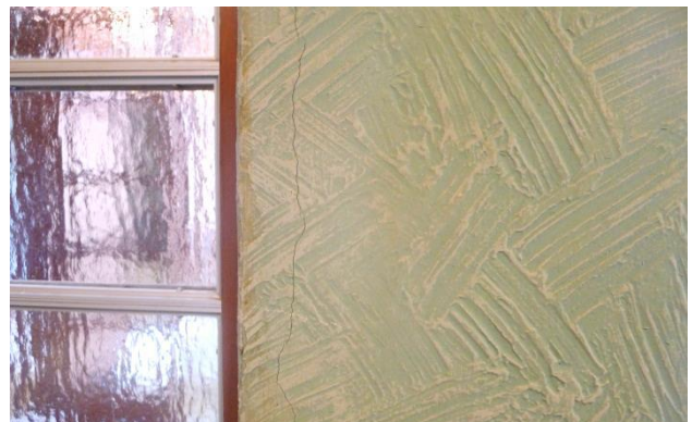
写真 7-8 ペンキを塗られたラフコート塗
