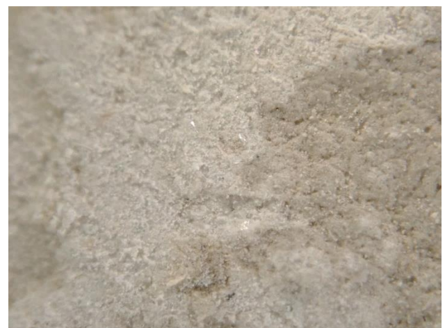
写真 7-3 ラフコート塗表面
