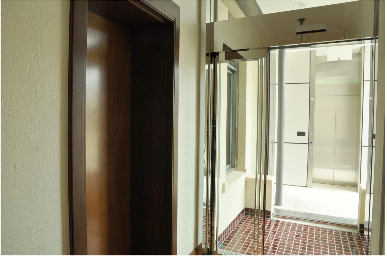
13 本館二階廊下、バルコニー（南面・竣工）
