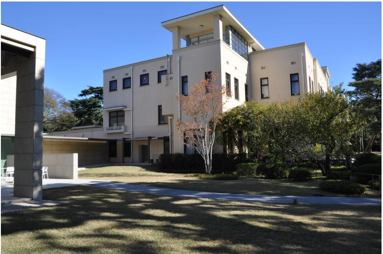
4 本館外観（西面・修理前）
