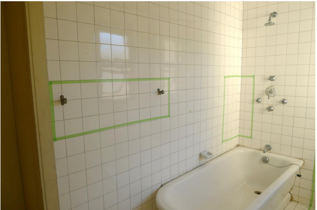
14 本館二階浴室（南面・修理前）
