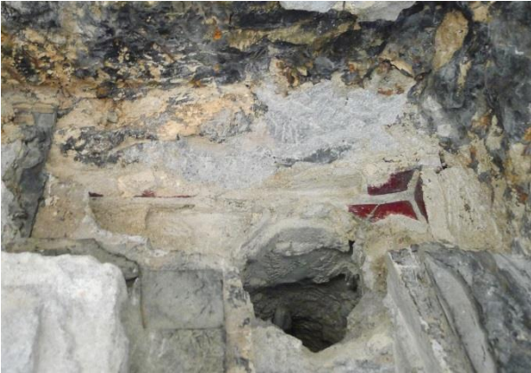
写真 4-1 幅木タイルと床タイル 残存していた床タイルはこの一枚のみだった。
