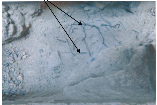
写真 2-3 スラブ切り調査写真
