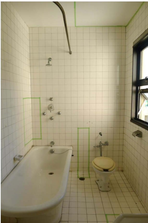
写真 1-3 工事前の浴室内部 東より見る
