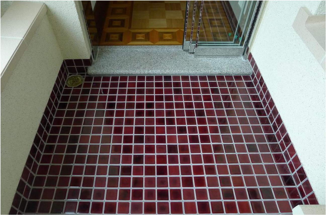
15 本館二階バルコニー（床面・竣工）
