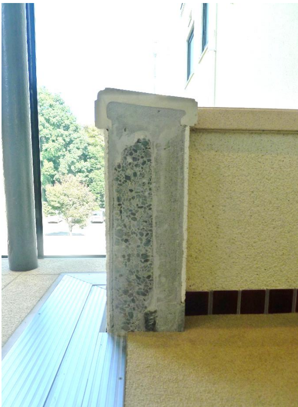
19 本館二階バルコニー躯体切断面（北側）
