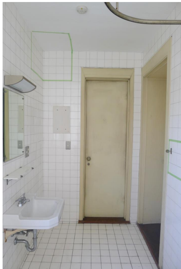
写真 1-4 工事前の浴室内部 西より見る
