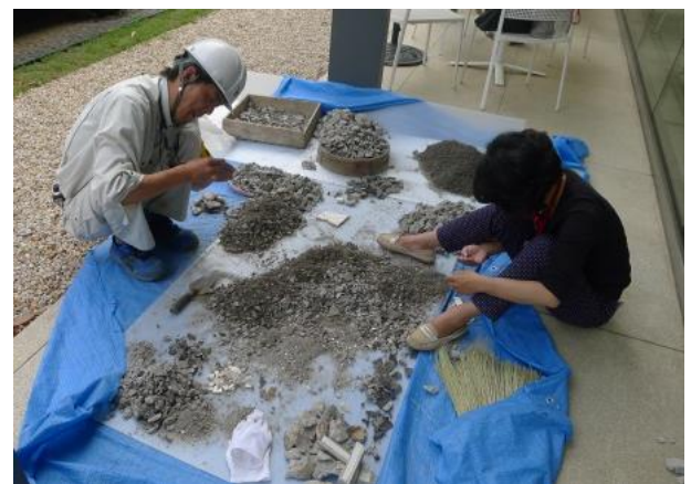
写真 4-8 当初タイルが混在していないか確認
