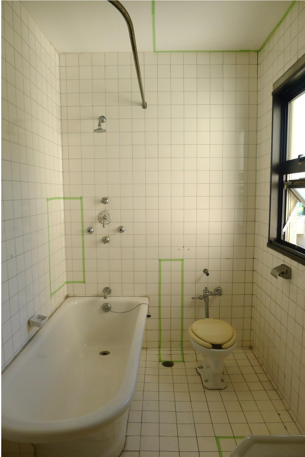
8 本館二階浴室（西面・修理前）
