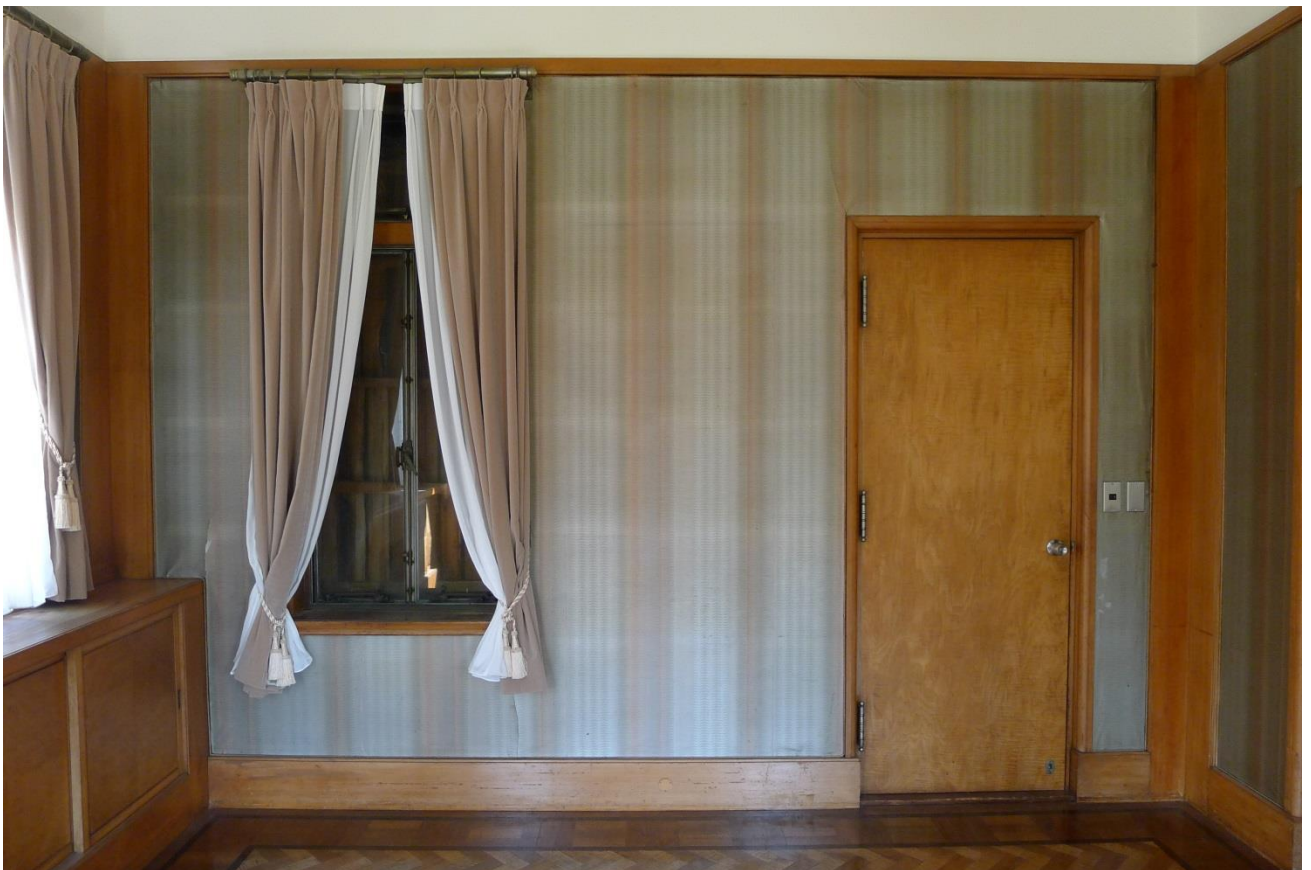
22 本館二階姫宮居間（北面・修理前）
