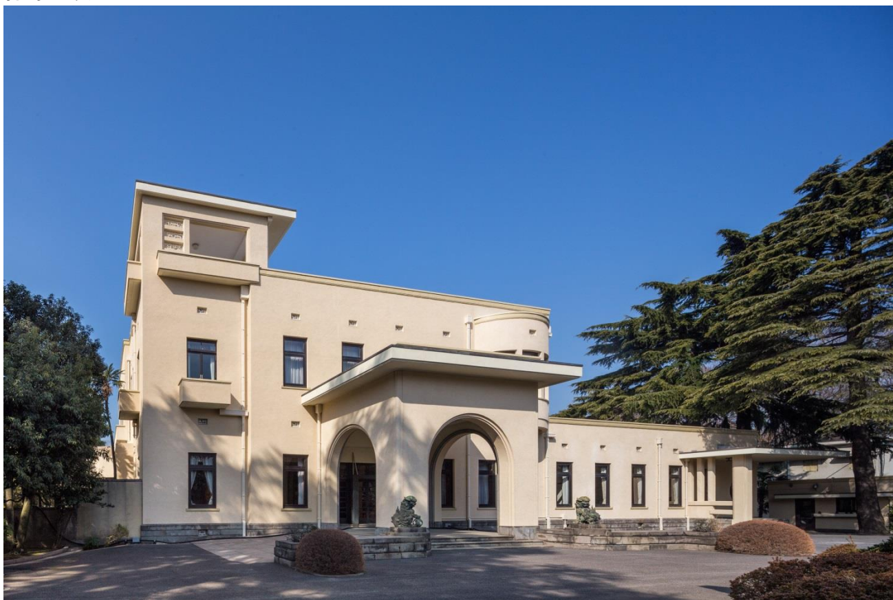
1 本館外観（東面・竣工）
