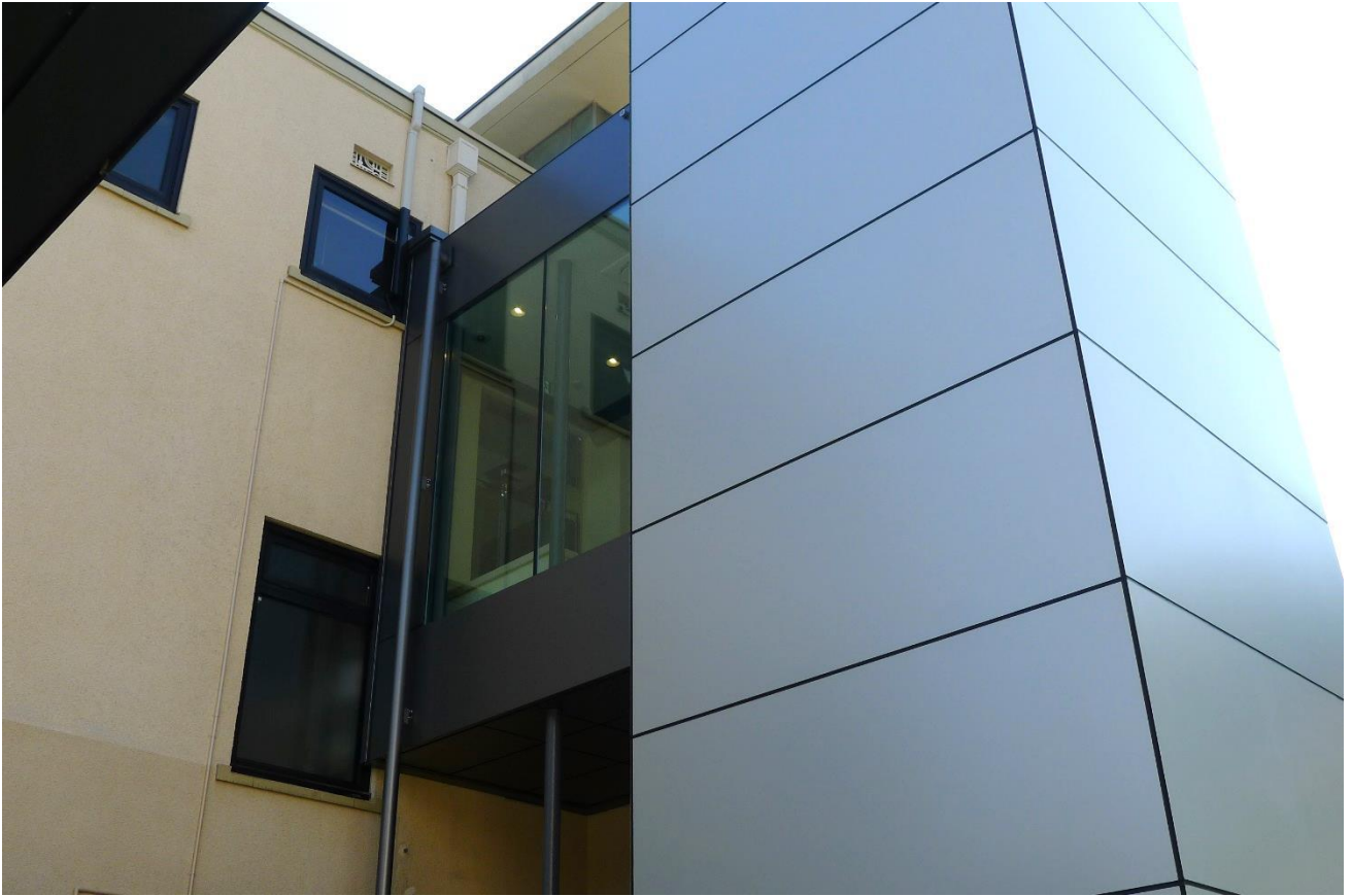
5 本館二階バルコニー外観（竣工）
