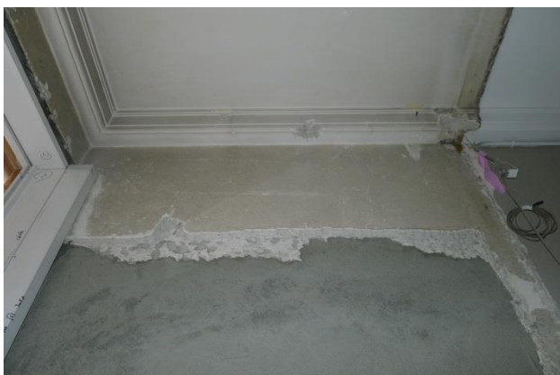
写真 7-2 浴室天井解体後
