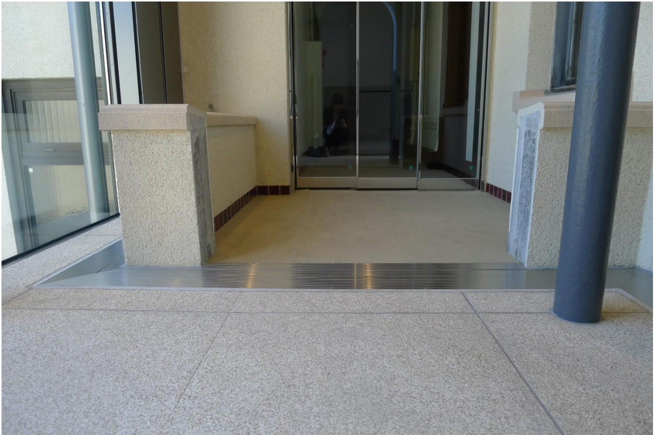
18 本館二階バルコニー躯体切断状況
