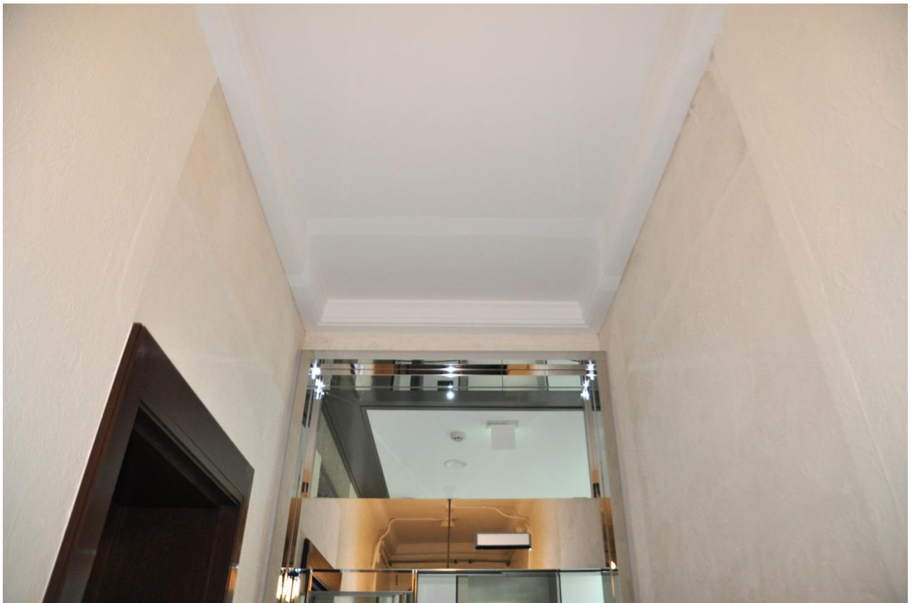
11 本館二階廊下（天井・竣工）
