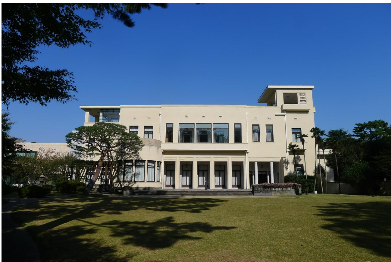
2 本館外観（南面・竣工）
