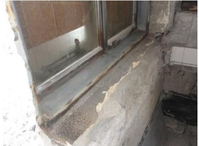
写真 5-2 姫宮寝室窓台テラコッタ（外壁側）
