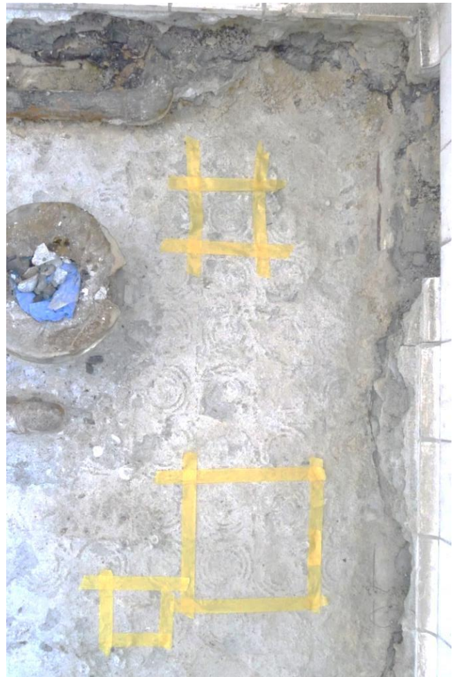
写真 2-2 タイル裏足痕 床全面に三重丸跡が残る。黄色テープはタイルを生産した「泰山製陶所」の「泰」の文字が確認出来る箇所。
