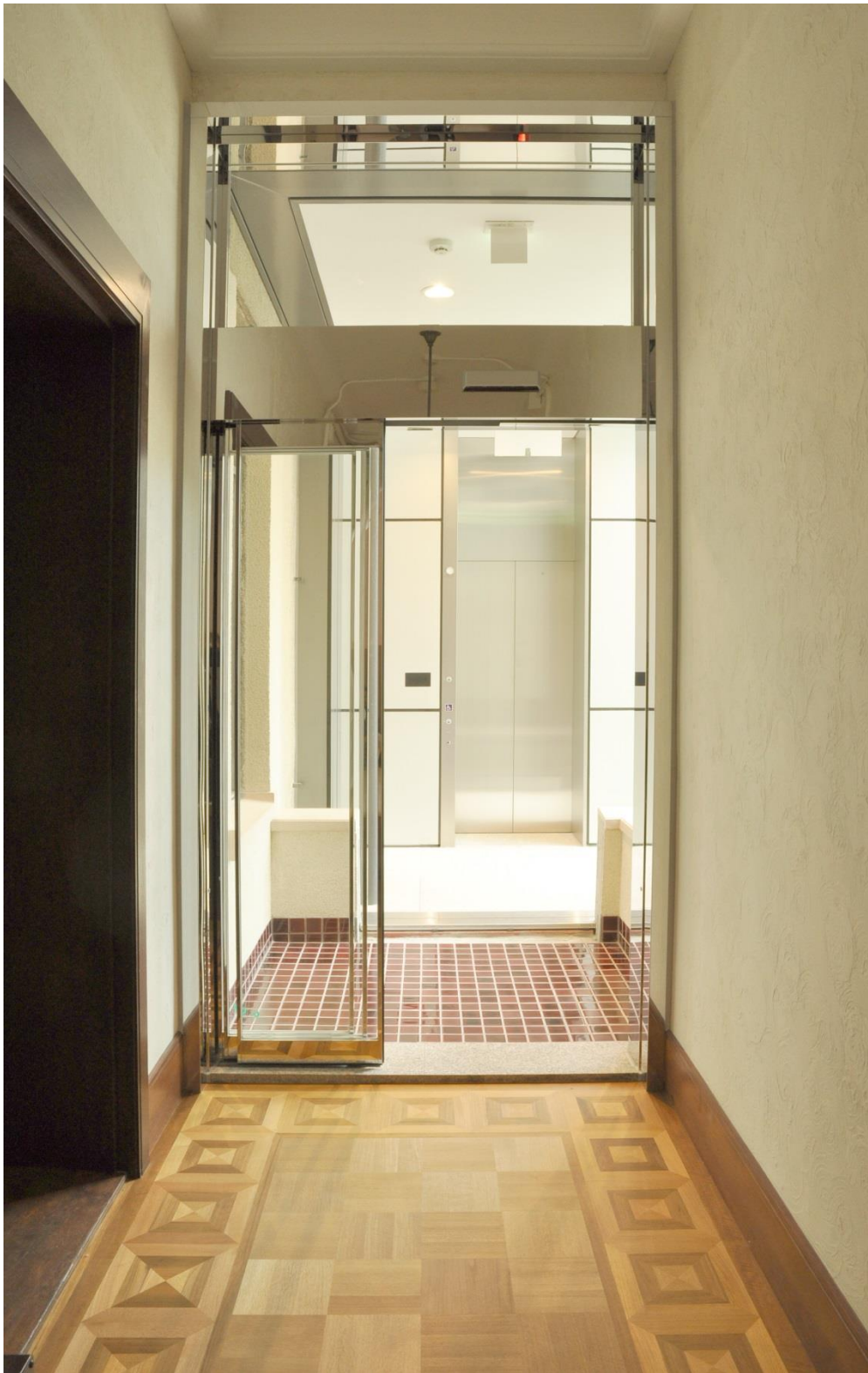
7 本館二階廊下、バルコニー（西面・竣工）
