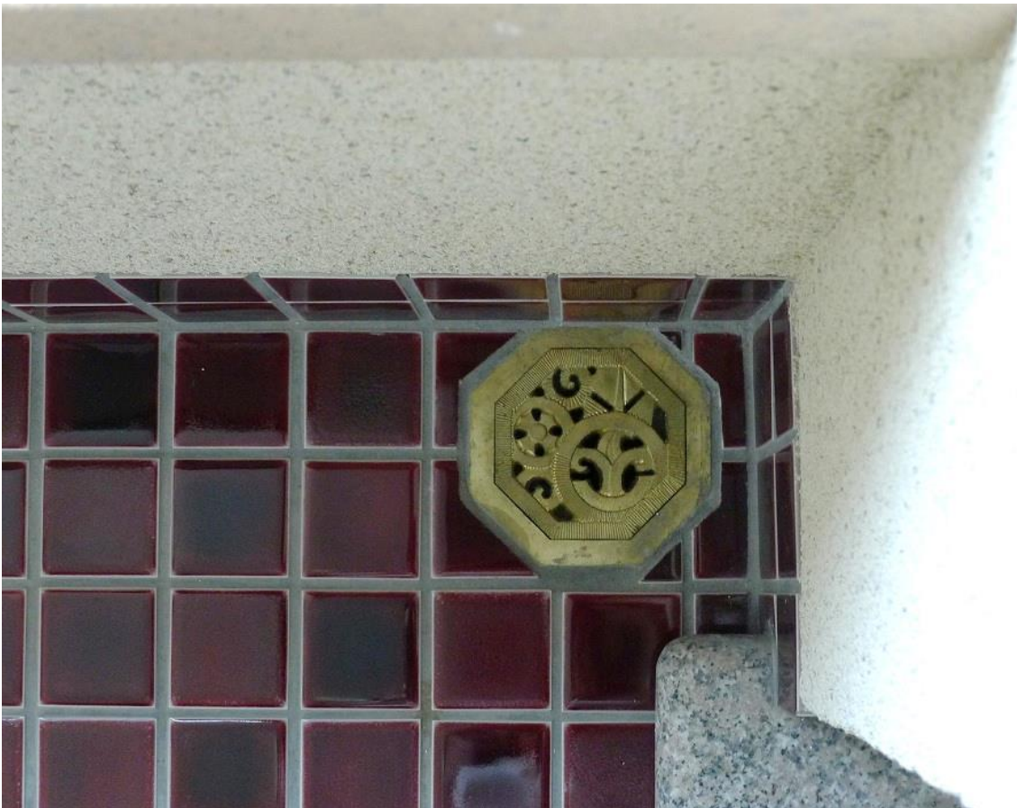
27 本館二階バルコニー（竣工）排水口を整備
