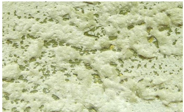
写真 7-7 2階合之間のラフコート塗 (拡大) 表面に金色の模様をつけている。
