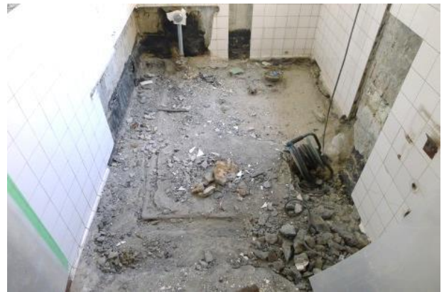
写真 4-7 浴室床タイル解体完了
