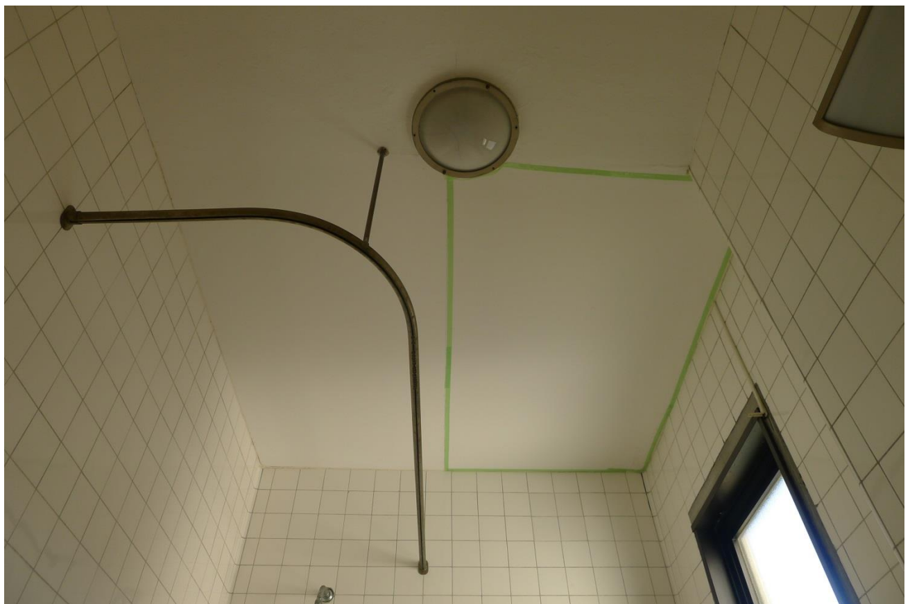
12 本館二階浴室（天井・修理前）
