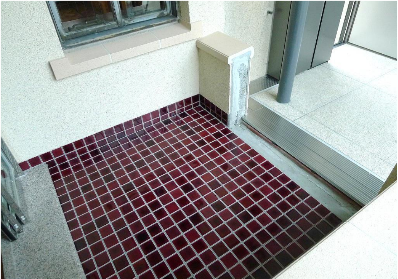
24 本館二階バルコニー（床面・竣工） 床タイル貼を整備
