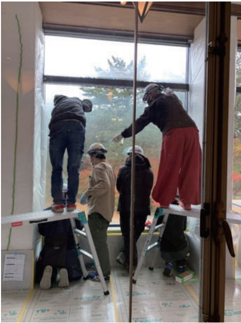
複層ガラス化工事の様子
