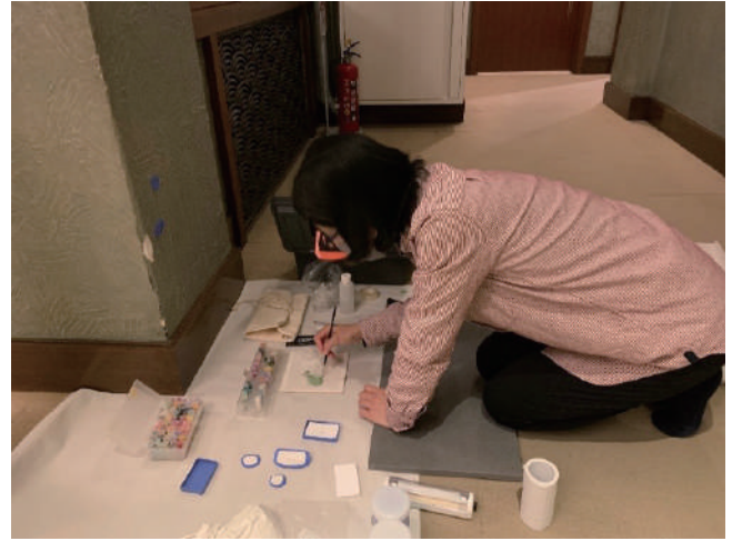
本館ラフコート壁修理の様子
