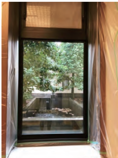
「アトッチ」施工の様子
