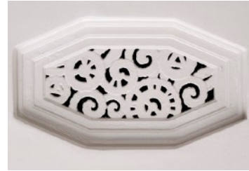
旧殿下居間の通気口
